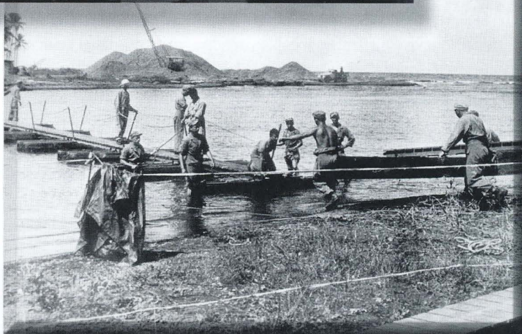
Construcción de puente de pontones sobre el Lago Gatún.
